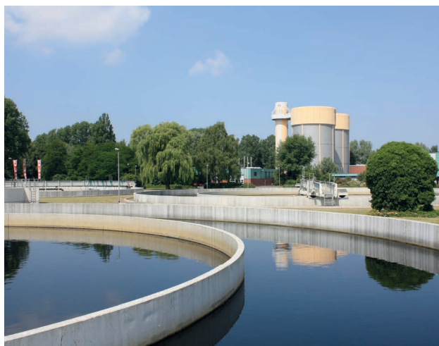
Zentralkläranlage der BEG.
